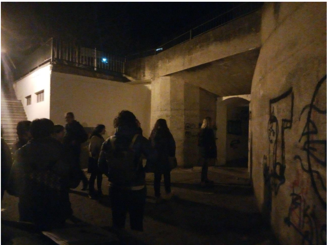
Pas subterrani al Parc dels Jubilats sense il·luminació i en mal estat de manteniment
