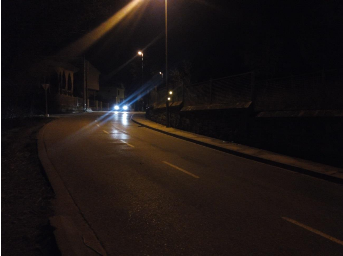
Vorera estreta i en corba a la Pujada del Seminari amb fanals al mig de la vorera
